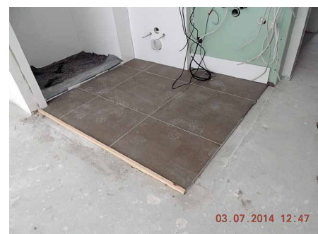
Abb. 3: Bodenbelag mit Fußbodenabdichtung
