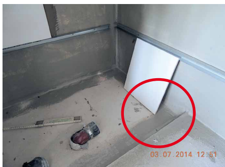
Abb. 2: Vertiefung zur Aufnahme der Duschtasse
