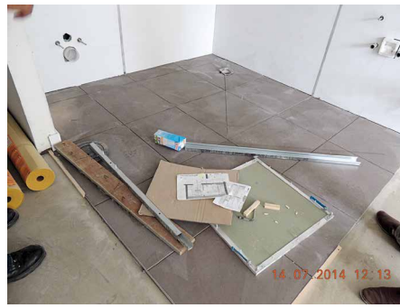
Abb. 5: niveaugleiche Dusche mit Fliesenbelag
